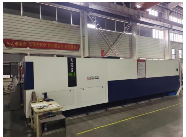
图为新港厂区喷涂车间燃气管道压力检测安全改造
