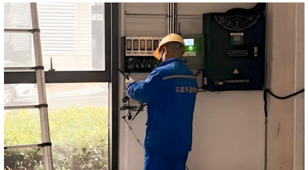
图为新港厂区喷涂车间燃气管道压力检测安全改造
