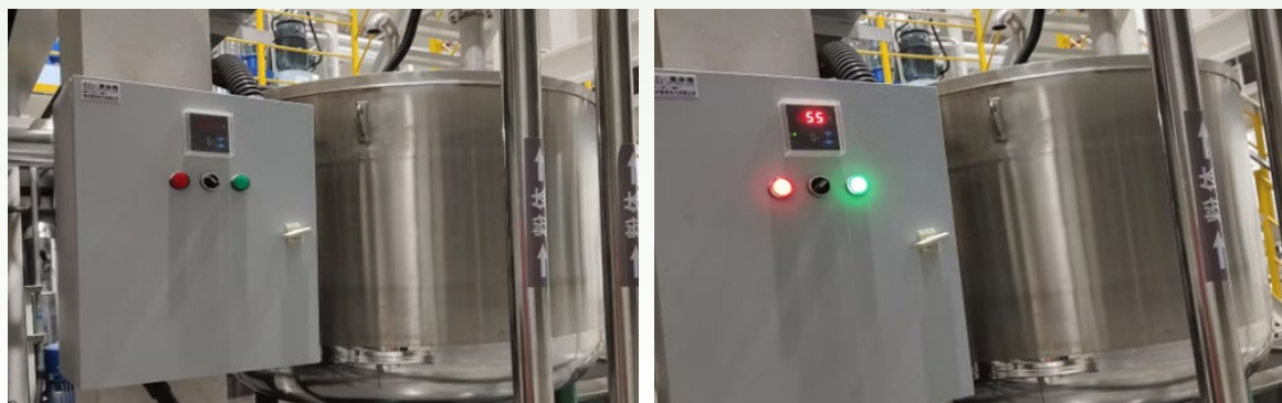
三棵树安徽工厂电加热保温改造前后对比图
