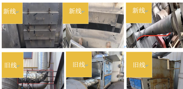
喷涂线新、旧线设备换线
