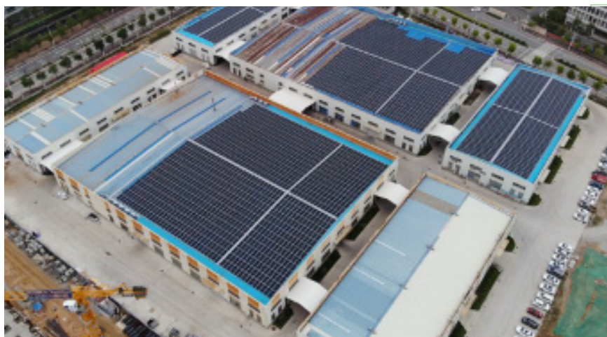
福建东恒安装屋顶光伏
