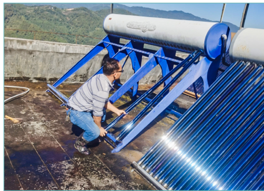
云南省腾冲市蒲川乡户弄完小的校舍修整现场
