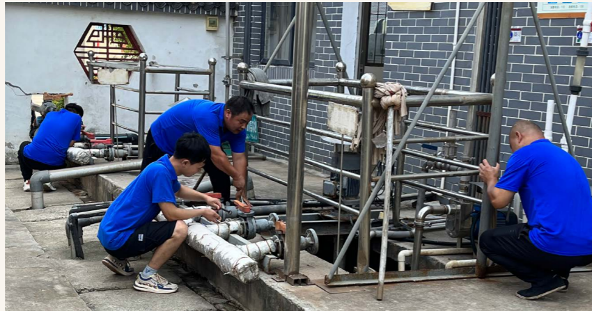
>> 废水异常排放应急演练
