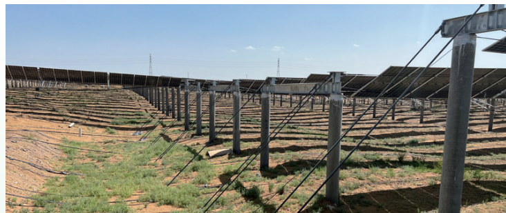
库布齐项目光伏治沙
