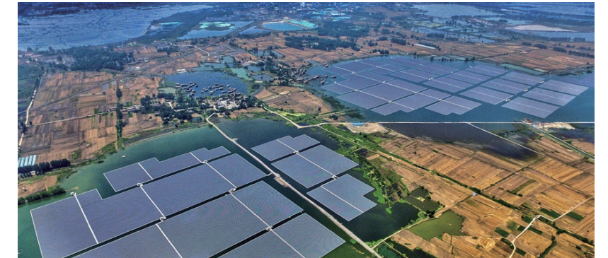
三峡能源安徽淮南水面光伏电站
