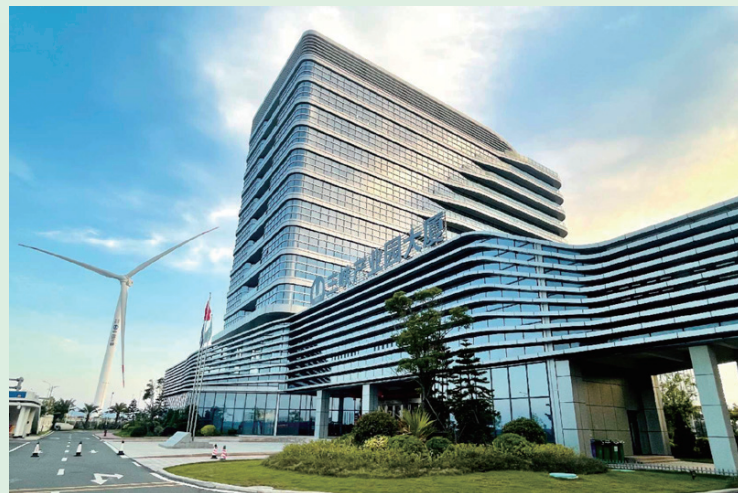
福建三峡海上风电国际产业园
