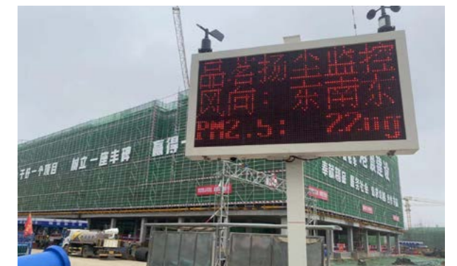
◎ 项目现场设置扬尘噪音风速仪
