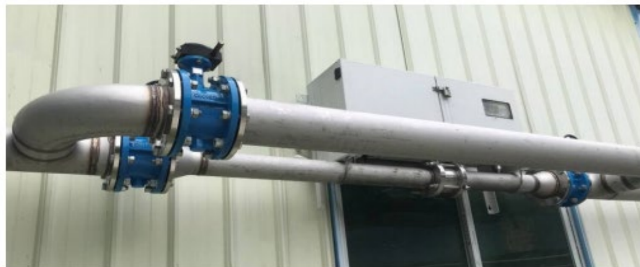
“空压机供气管道更换”方案
