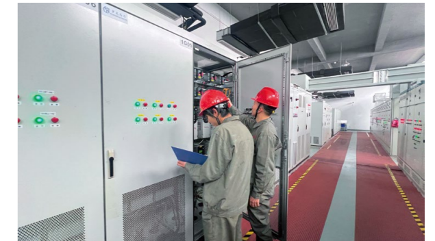
安全检查现场
