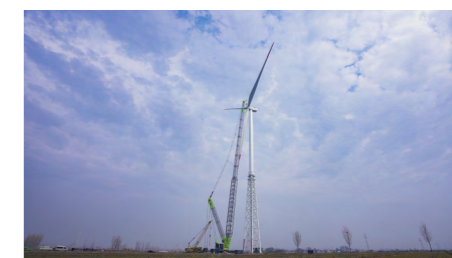
国内首台 165 米级预应力钢管混凝土格构式塔架
