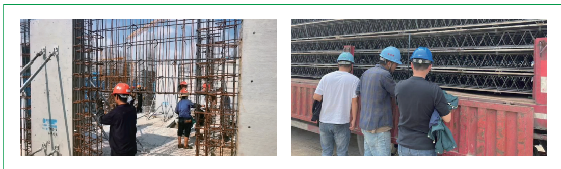
紫星堂桁架楼承板
