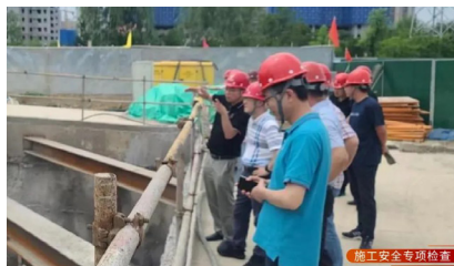
施工安全专项检查
