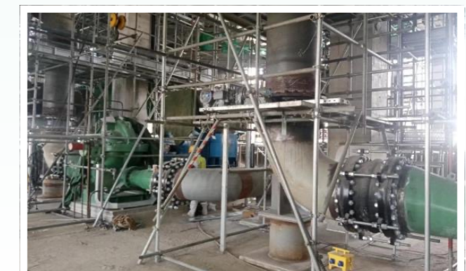
图：核电项目现场
