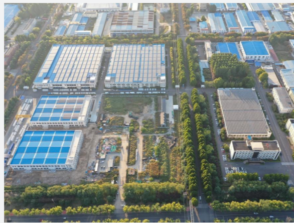
3.17MW 屋顶分布式光伏发电项目
