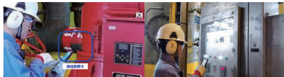
工作人员使用5G终端接收巡检任务单并进行现场巡检
