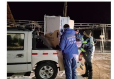
信科移动新疆代表处工程师通宵紧急开通应急基站
