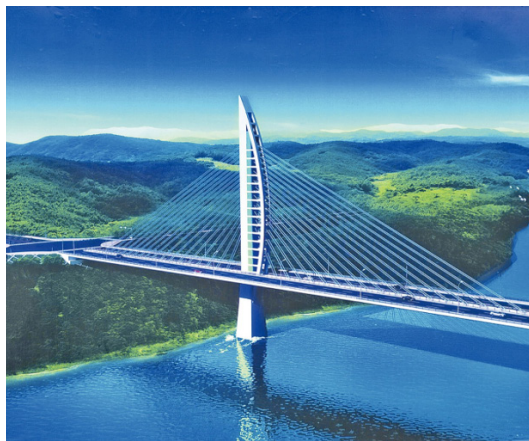
四川达州跨铁斜拉桥转体施工监测
