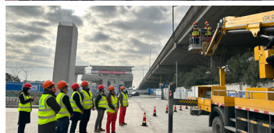
集团开展重大事故隐患排查
