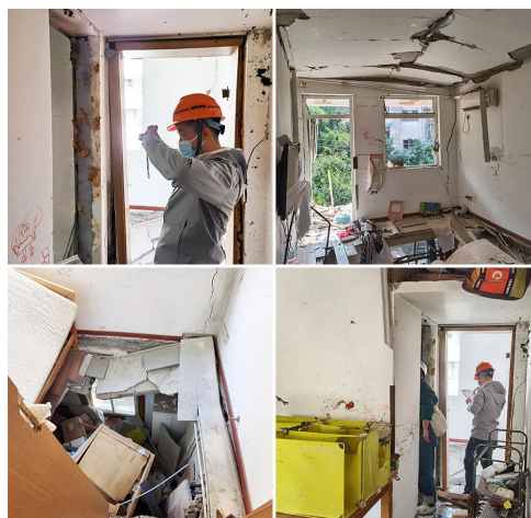
房屋安全检查现场工作
