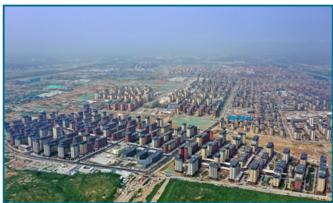
河北省雄安新区容东片区、容西片区、雄东片区安置区工程
