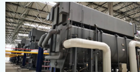
补燃型溴化锂吸收式换热系统
