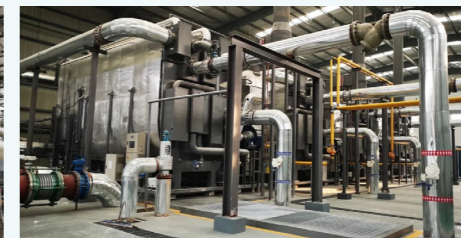
补燃型溴化锂吸收式换热系统
