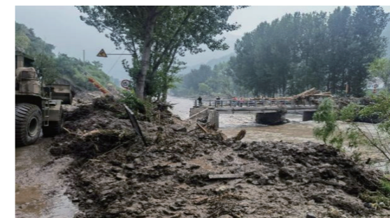
▲ 出入村道路已经被冲垮
