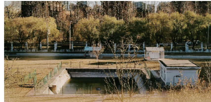
▲ 中水处理及绿化蓄水池
