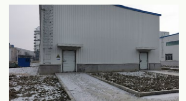
危险废物贮存间
