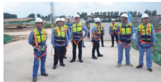
项目现场开展安全检查
