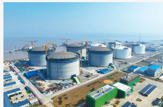
舟山接收站三期施工现场鸟瞰图
