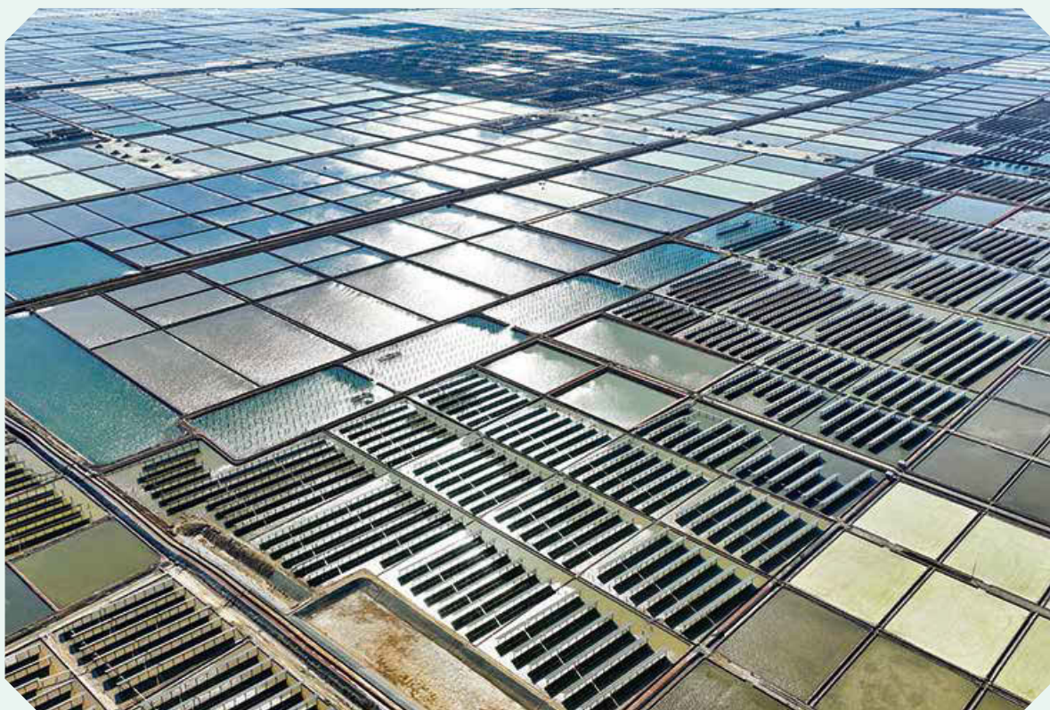
华能山东山盐150兆瓦光伏发电项目
