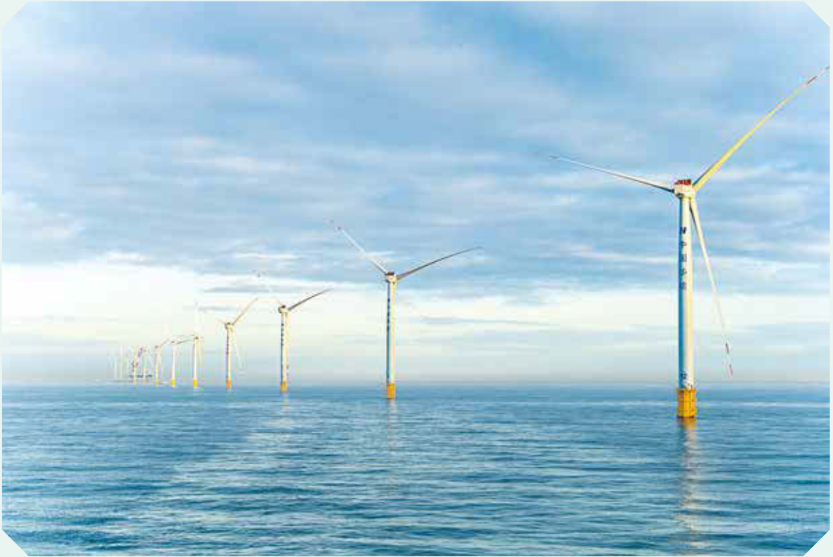
华能广东汕头勒门(二)594兆瓦海上风电场项目
