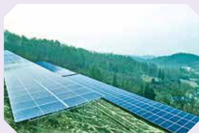
华能湖北分公司建设高家沟村屋顶光伏
