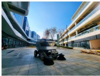
长沙-中建智慧谷产业园
