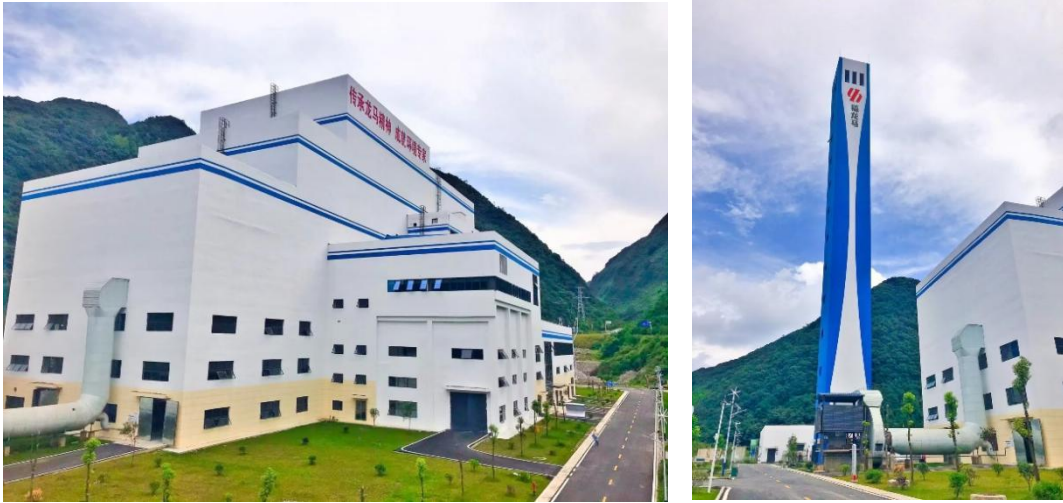
六枝焚烧发电厂
