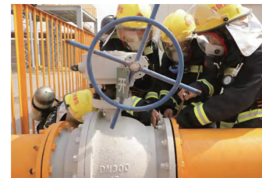
天然气泄漏应急演练
