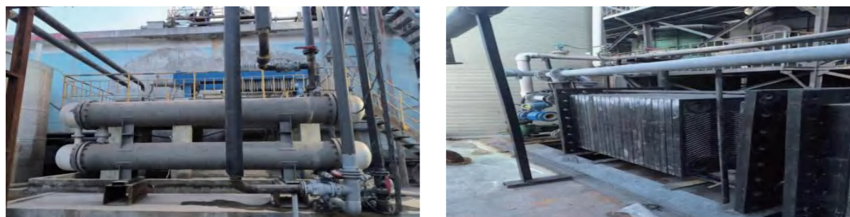
现场安装浸润石墨板板式换热器
