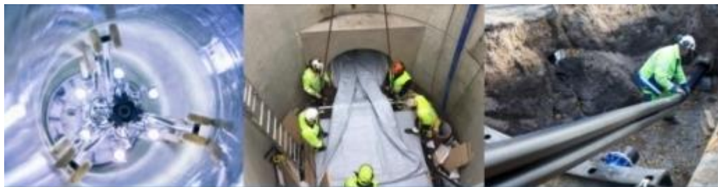
图 14 非开挖修复工程案例
