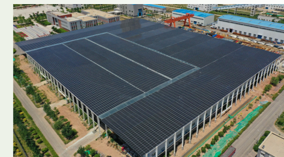
西部能源 6MWp 分布式光伏电站
