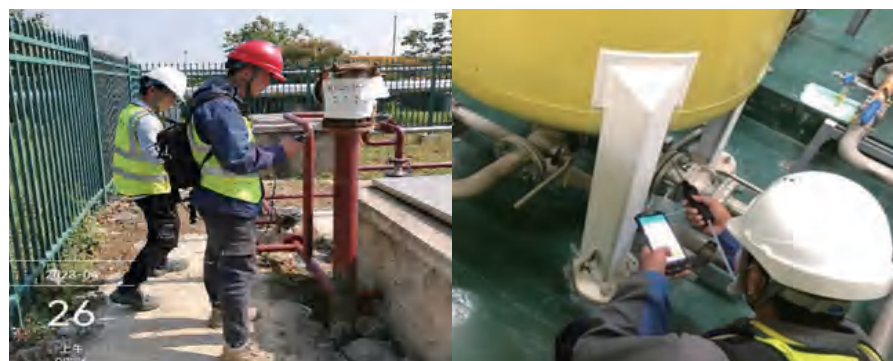
开展LDAR管道泄漏检测
