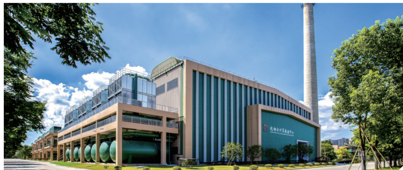
杭钢云计算数据中心
