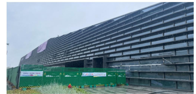
综合体项目的建设现场
