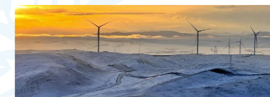
西藏那曲色尼区 100 兆瓦风电项目全容量投产
