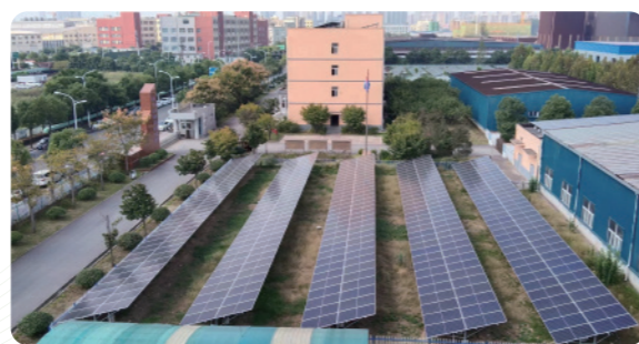
分布式光伏发电项目
