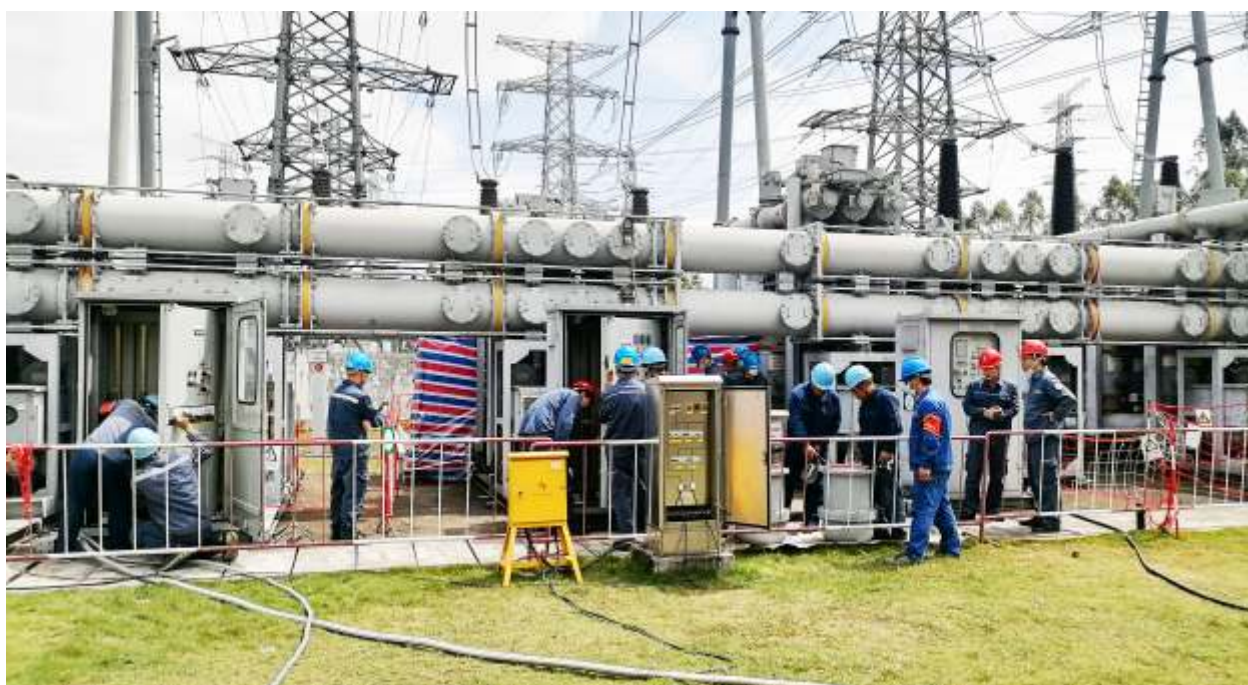
衡变公司检修人员对广州供电局项目进行检修
