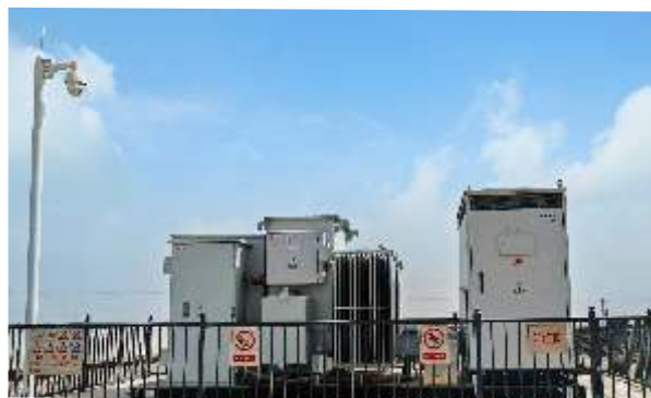
公司成功研制的非晶立体卷铁心光伏逆变升压一体机
