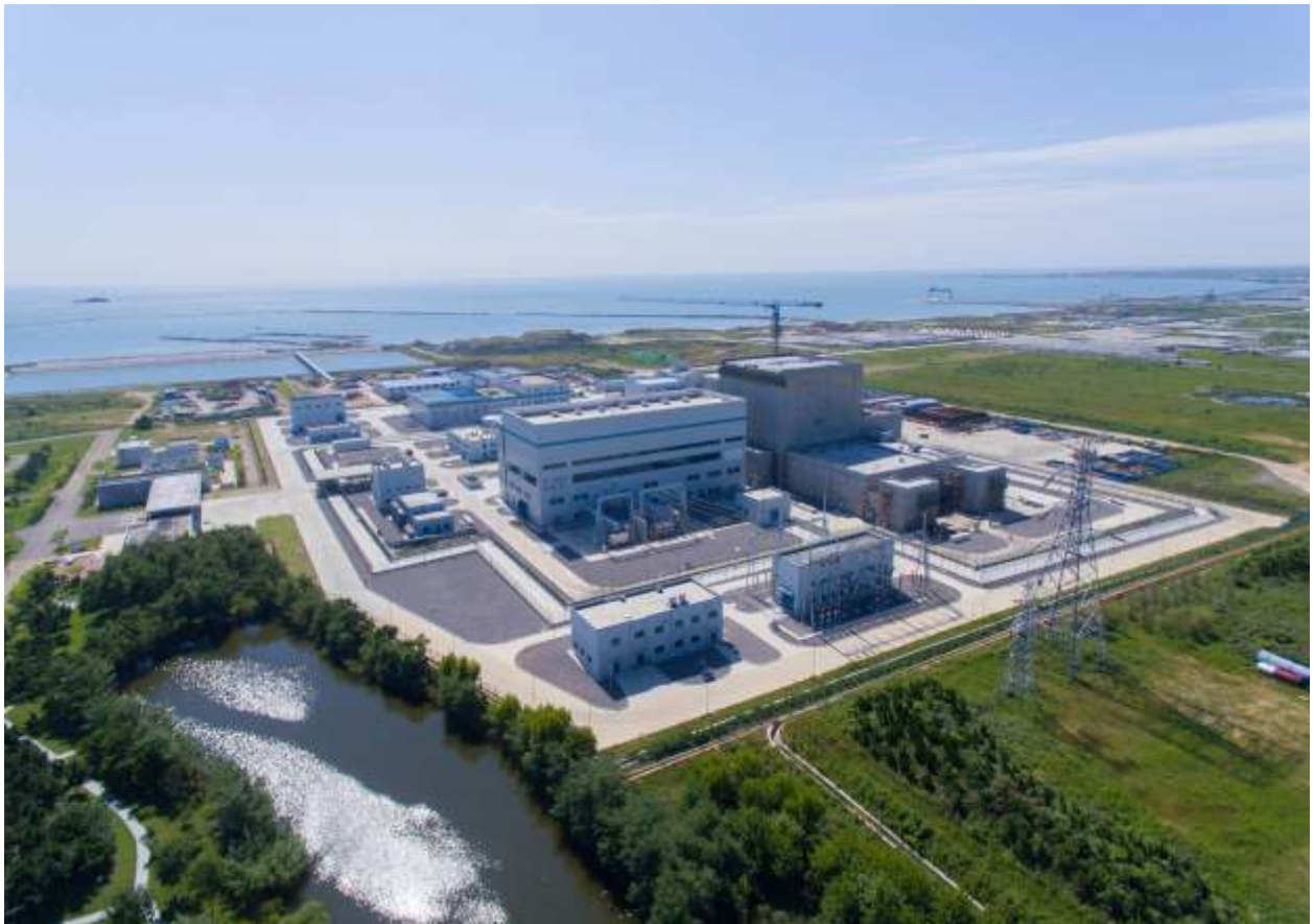
沈变公司为华能石岛湾高温气冷堆核电站示范工程成功研制了1台220kV240MVA升压变压器、1台18kV36MVA厂用变压器及1台110kV63MVA辅助变压器
