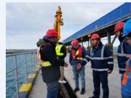
土耳其胡努特鲁电厂及码头施工单位检查震后受损轨道
