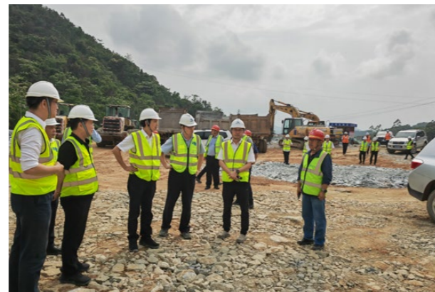
南网储能公司总经理、党委副书记李定林带队开展安全生产检查
