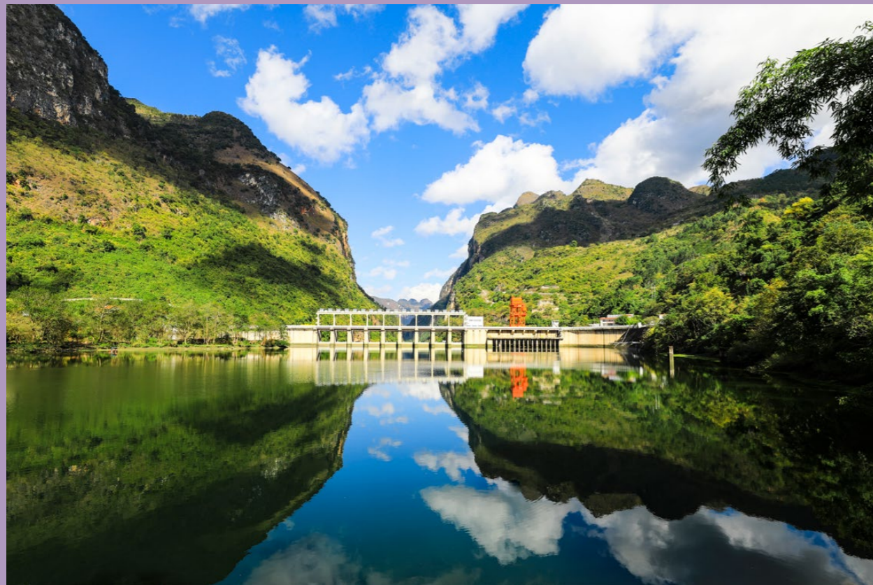
天生桥二级水电站
