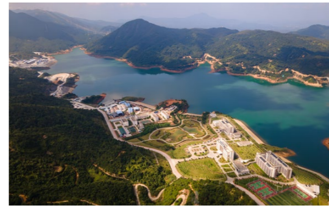
梅州抽水蓄能电站
