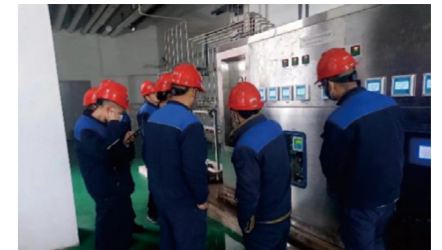
安全隐患排查
