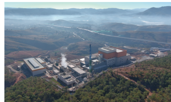
四川会东项目实景图 ▶
