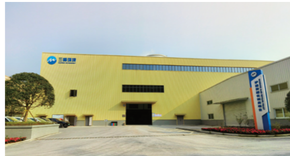
炉渣资源化利用项目
