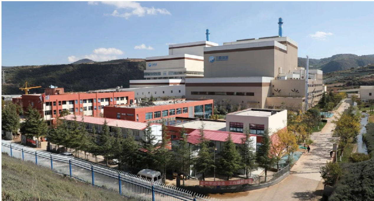
昆明空港垃圾焚烧发电项目
