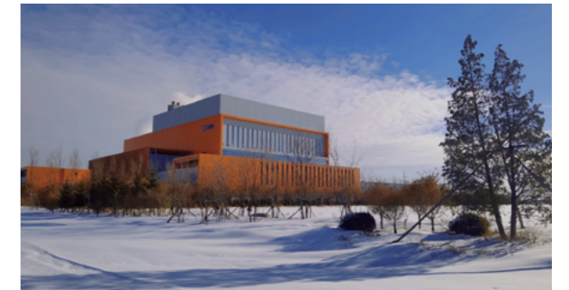
鞍山市三峰环保发电厂
