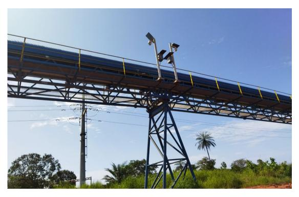
架空栈桥带式输送系统
