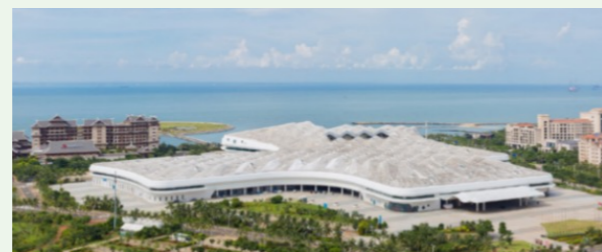
中建八局 - 海南国际会展中心
