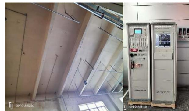
变电所火灾自报系统的修复和消防主机的移机，安装烟感探测，将消防主机移到安防中心，利于24小时专人监控。
