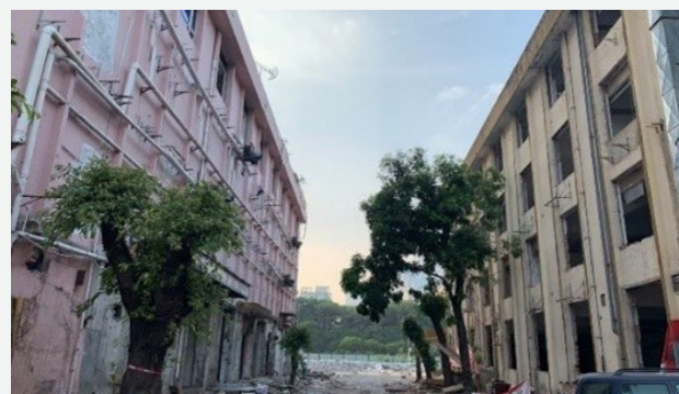
项目拆除前面貌
