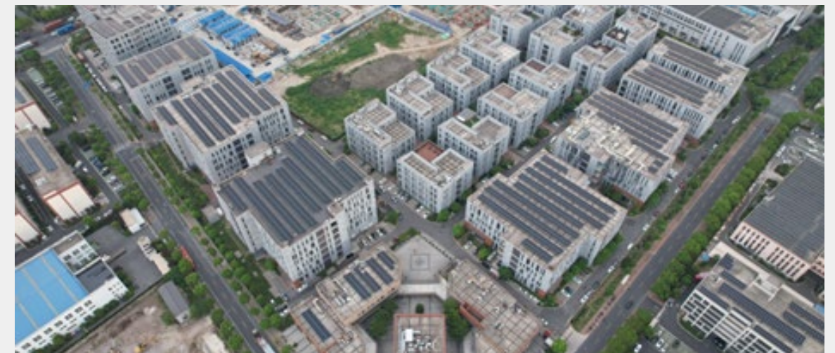
嘉定产业园光伏改造项目
