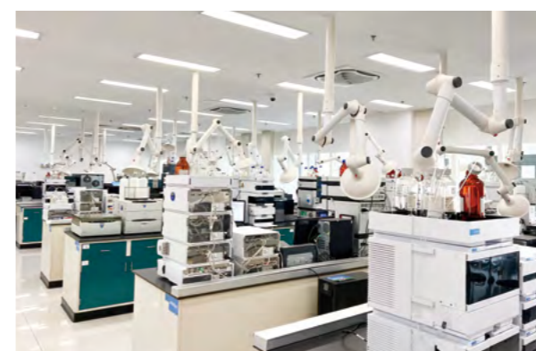
检测控制中心仪器分析室
