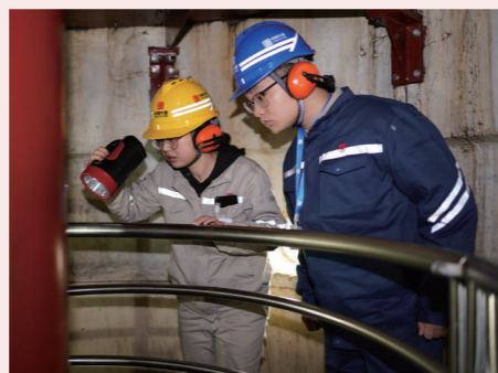
▲沿渡河公司组织开展设备隐患排查工作
