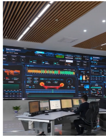
陕西煤业煤炭板块级工业互联网平台
