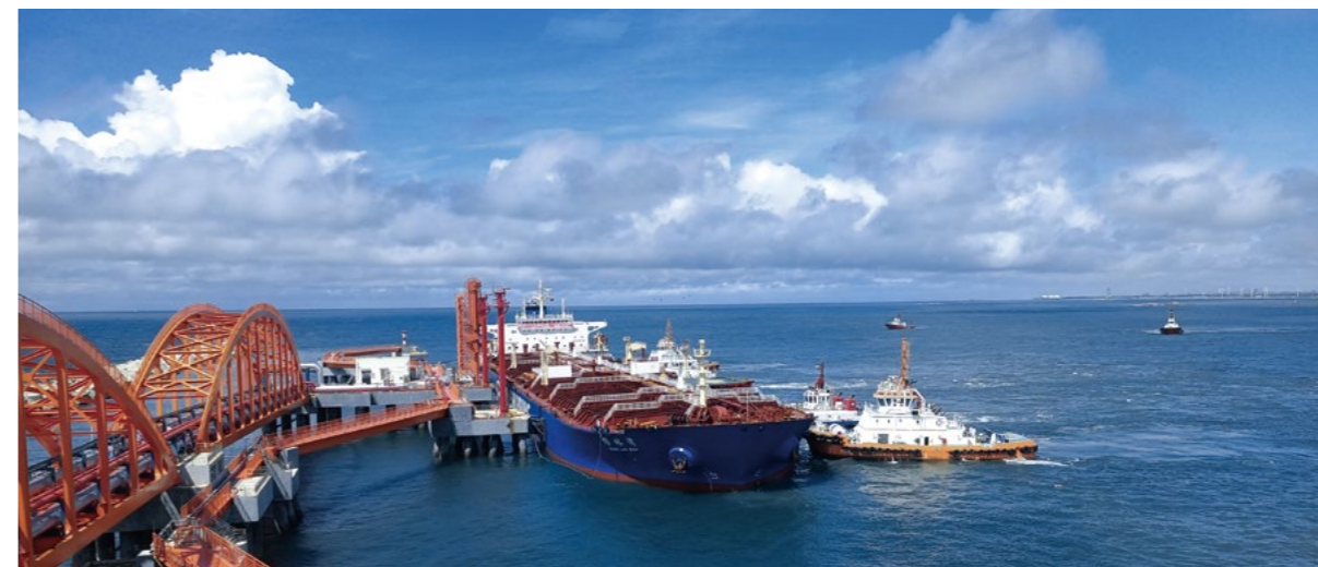
“杨林湾”轮为广东石化炼化一体化项目成功引进首批油品
