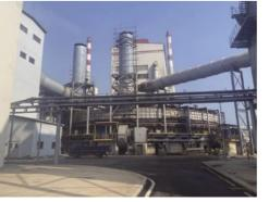
J科技有限公司是一家专业从事余热余能发电、脱硫脱硝、除尘、污水处理的公司。2023年初,J公司向公司融资 2.83亿元用于其工业废气脱硫脱硝项目,该项目 2 号、3 号烧结机机头烟气各自经一套"双室四电场静电除尘器(利旧)+CFB循环流化床半干法脱硝+覆膜袋式除尘器+GGH+SCR中温脱硝反应器"设施处理后再外排,确保废气排放严格执行《钢铁工业大气污染物超低排放标准》(DB13/2169-2018)相关要求。
