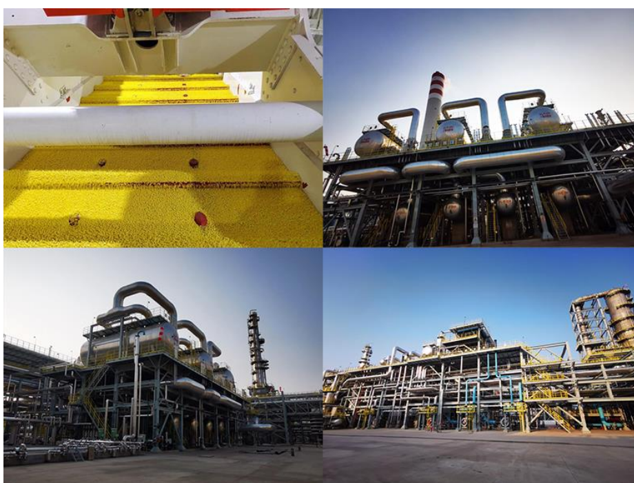
盛虹炼化一体化项目 4×15 万吨/年硫磺回收联合装置开车一次成功（图）
