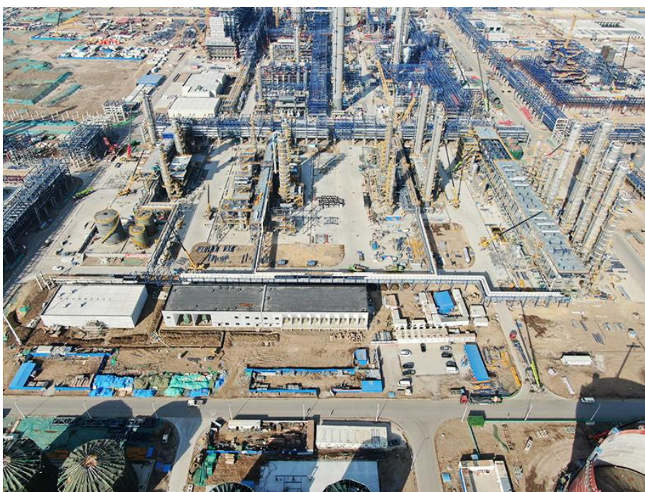
天津南港 120 万吨/年乙烯及下游高端新材料产业集群项目（EPC）（图）
