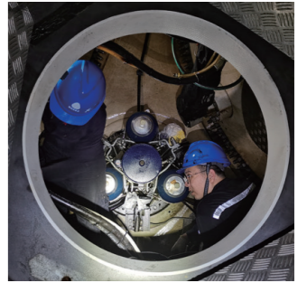
福能新能源风机变桨油缸缸头密封圈技改
