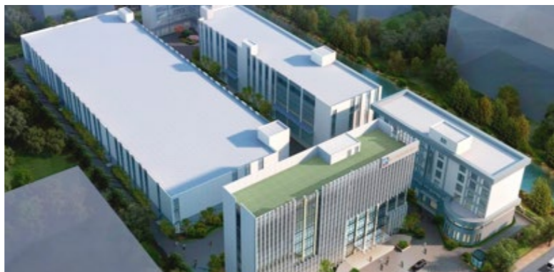
杭州大江东富栖云数据中心
