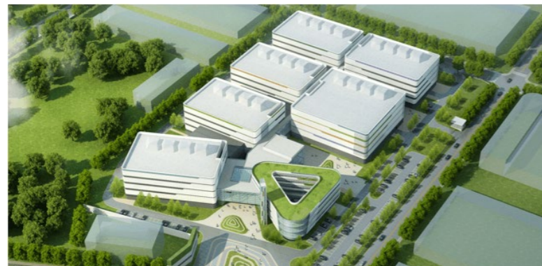
杭州富阳数据中心
