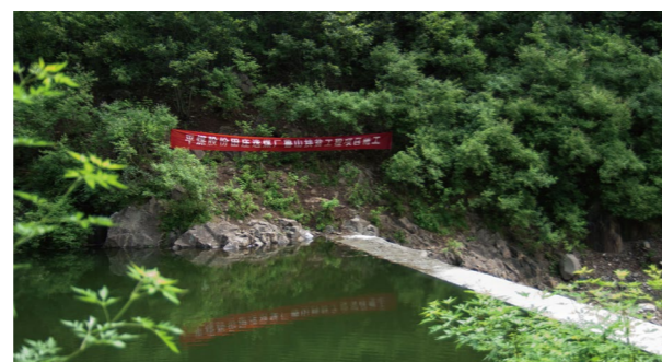
重修水坝工程
