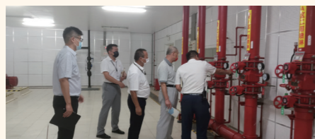
聘请专业机构对重点单位进行隐患排查
