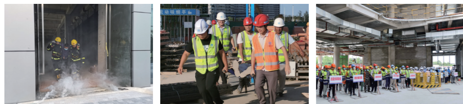
投资公司开展消防应急演练 投资公司在建项目开展物体打击应急演练 投资公司在建项目开展消防应急演练
