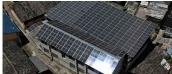
屋顶光伏项目
