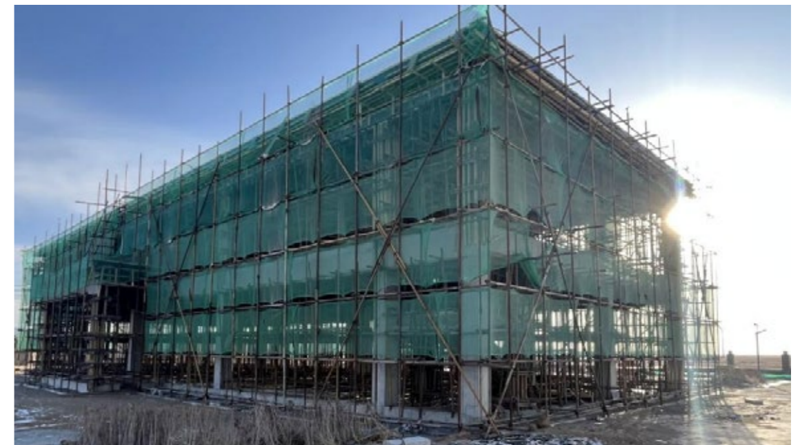
苏尼特右旗“蒙医医院”施工现场
