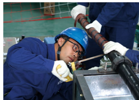
电气队在实训室进行 10 千伏电缆头制作演示
