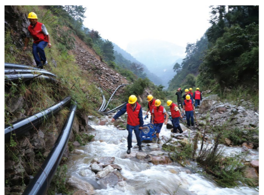
抢修受损供水系统
