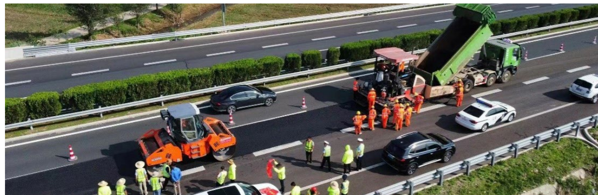
岚菏高速养护施工现场
