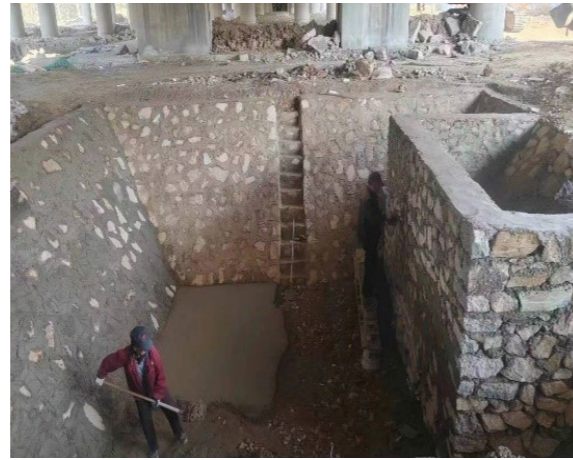
京台济泰改扩建项目油水分离池现场施工现场
