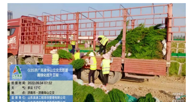
济广高速绿化工程现场
