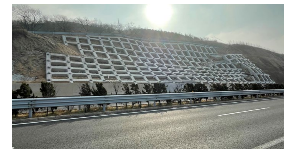
水毁维修现场
