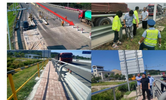
泰东运管中心平阴玫瑰收费站增设员工通道
