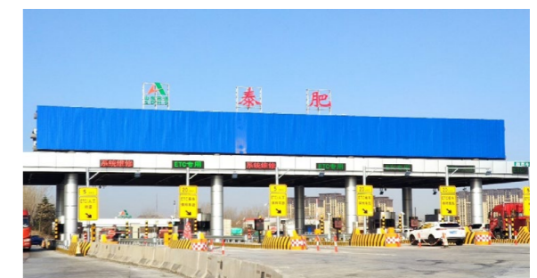
泰肥收费站改建工程竣工
